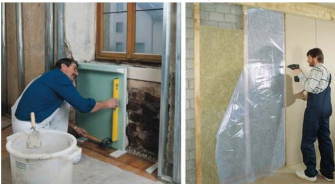
*Bild: Verbundplatte aus Gipskarton und Dämmung mit Formteil zur Montage der Fensterbank; Schichtaufbau einer Innendämmung (aus Heft 11 „Wärmedämmung von Außenwänden mit der Innendämmung“ der Energiesparinformationen Hess. Ministerium für Umwelt, Energie, Landwirtschaft und Verbraucherschutz)*
